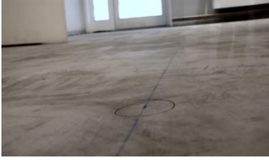
1. 설치 바닥면 샌딩후 설치 기준점 생성
